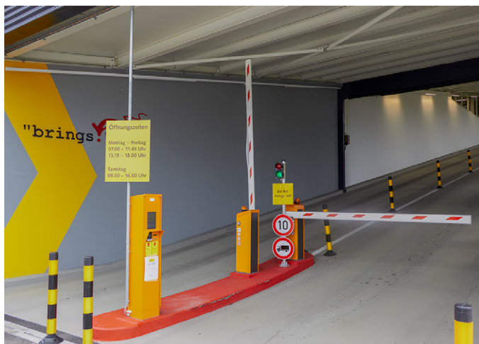
Les barrières à l'entrée et à la sortie régulent le flux de circulation sur le site.
