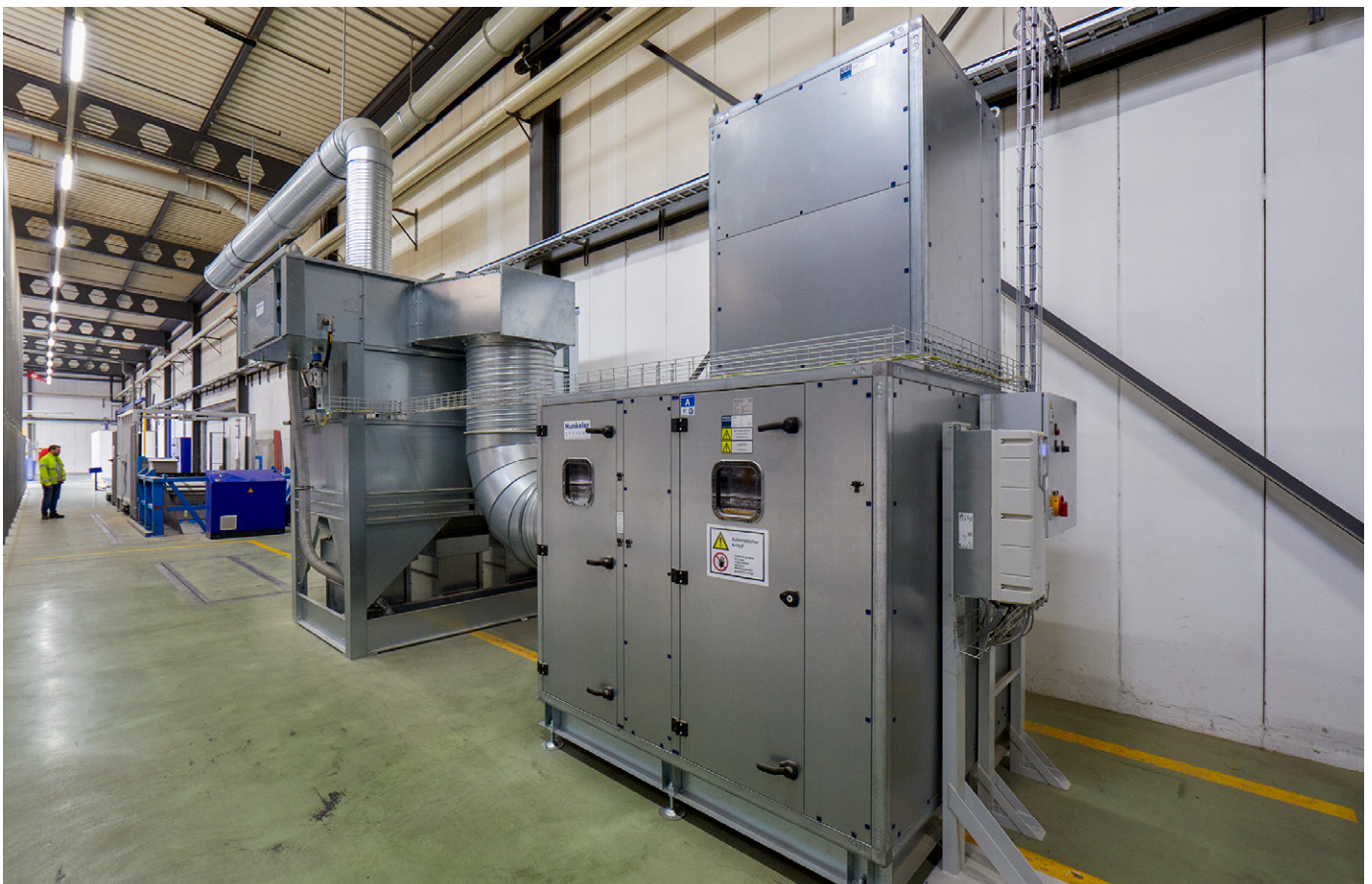
In der Entstaubungsanlage gereinigte Prozessluft trägt zu einem sauberen, von Kartonstaub befreiten Raumklima bei.
