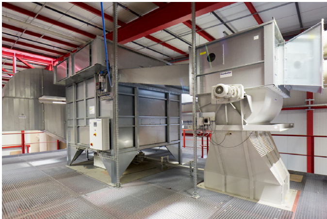
Eine kompakte Absauganlage bestehend aus Abscheider, Filter und Ventilator mit Energiesparsystem bildet das Herzstück des Systems.
