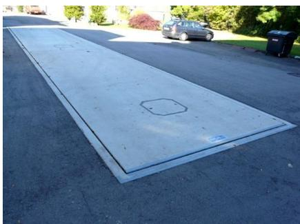
**Les ponts-bascules** servent à enregistrer les quantités de matériaux recyclables. Les véhicules sont pesés avant et après le chargement ou le déchargement des matériaux recyclables et les quantités et les poids enregistrés sont transmis au système de gestion pour la facturation et la tenue des statistiques. Les ponts-bascules peuvent également être utilisés lors des collectes de matériaux recyclables, ce qui permet d'assurer la transparence et la sécurité.
