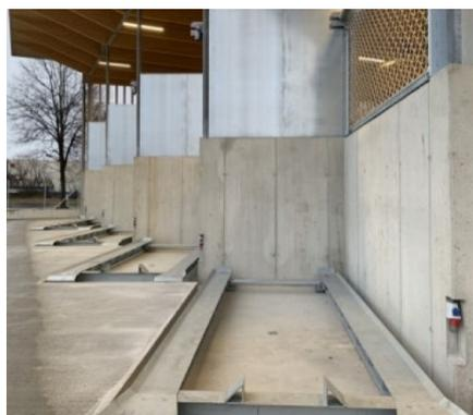
**Les balances pour conteneurs** sont conçues pour peser les conteneurs traditionnels comprimés et déroulés. Le conteneur complet est positionné sur la balance pour conteneurs. Chaque dépôt peut ainsi être saisi, pesé et facturé au client d'élimination conformément au principe du pollueur-payeur. De telles balances ont typiquement une capacité de 15 t pour une précision de mesure de 2 kg.
