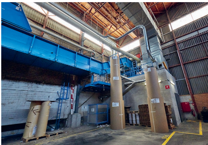
Eine gross dimensionierte Entsorgungsanlage stellt in der Wellpappenproduktion einen kontinuierlichen Prozess im 24/7-Stundenbetrieb sicher.
