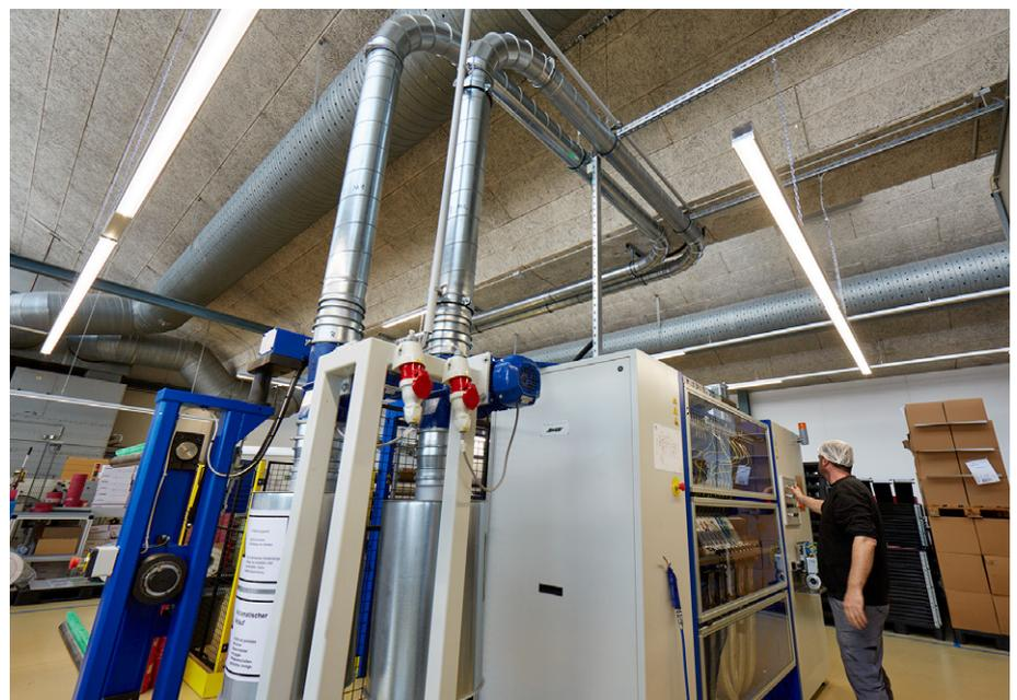
À une vitesse de 600 mètres par minute, les bandes de plastique sont broyées dans l'unité de coupe et évacuées par des canalisations.
