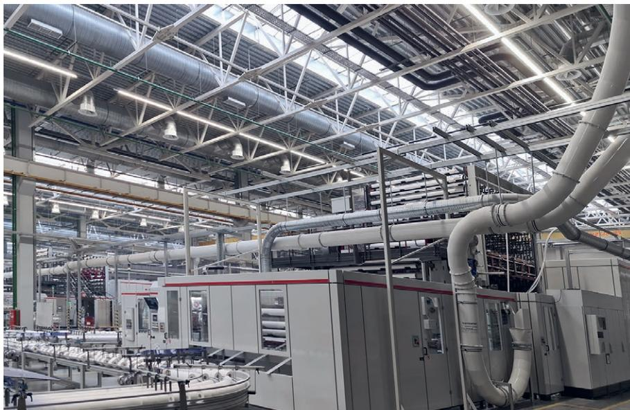
La technique de Hunkeler Systeme AG est raccordée à 42 places d'aspiration. La poussière produite pendant la production, est complètement évacuée, l'air de transport propre est reconduit dans l'environnement.
